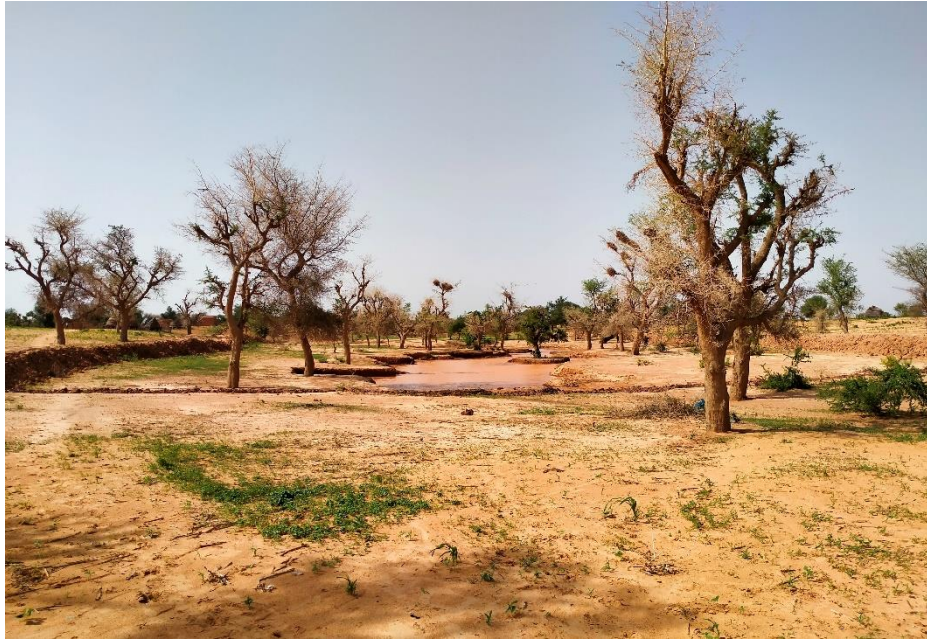
Photo 2 : Vue en amont de l'axe du site
