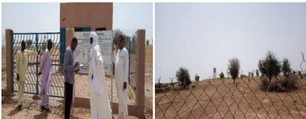
Photo 8 : Aperçu du système de captage et du réservoir d'eau de la MAEP du village de Kao.
