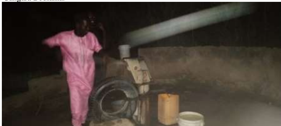
Photo 6 : Aperçu du FPMH existant du village de Gangara Boulama/Mirriah.
