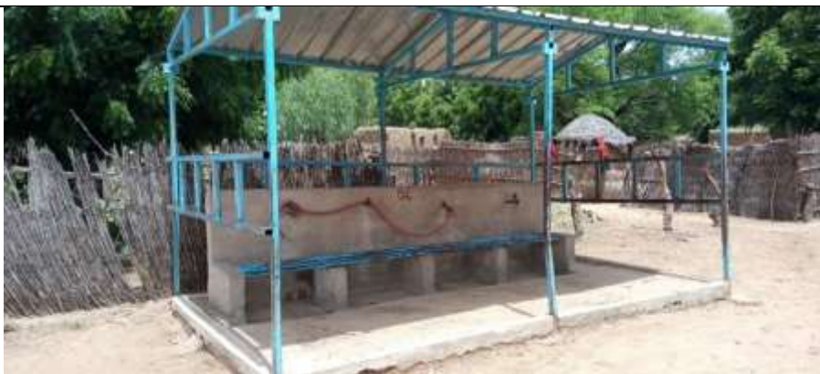
Photo 13 : Aperçu de la rampe d'eau de Dan Dila/Bandé.
