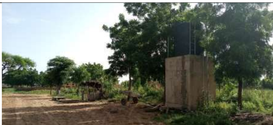
Photo 17 : Aperçu du réservoir et de la rampe d'eau de Birgi Babba/Kourni Source : mission terrain, octobre 2022
