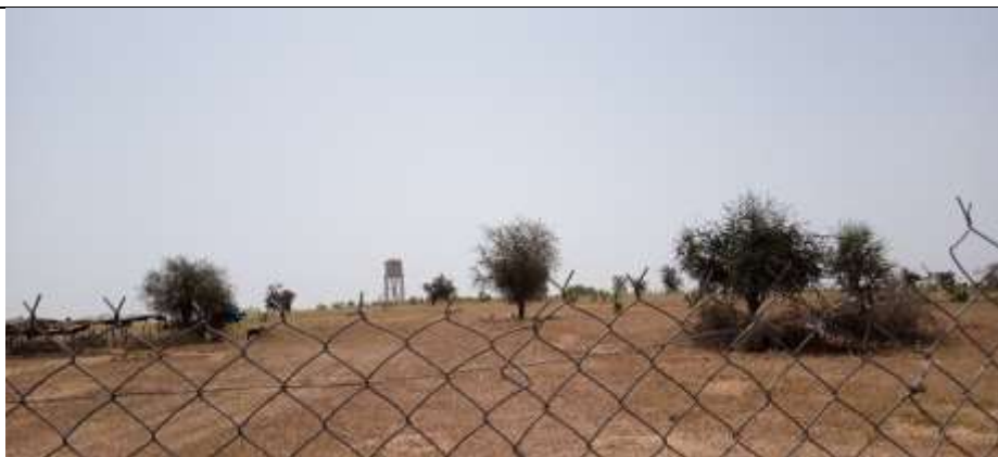
Photo 33 : Aperçu du réservoir d'eau de la MAEP du village de Kao.
