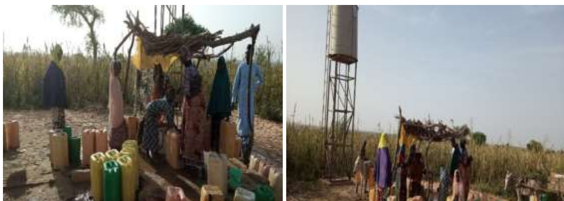
Photo 7 : Aperçu de la rampe d'eau et du réservoir d'eau du système de Tsana Assanaga/Karofane.
