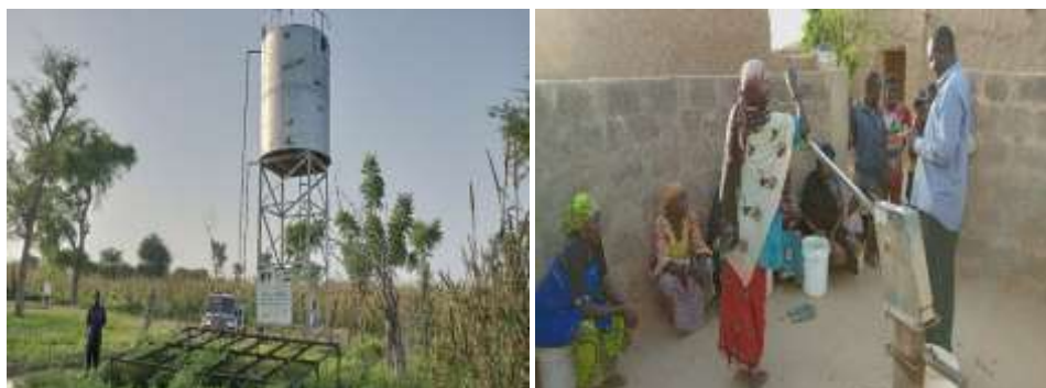
Photo 21 : Aperçu du PEA et du FPMH fonctionnel à Angoul Malan/Mirriah.
