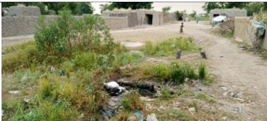
Photo 11: Aperçu de l'habitat et l'exécutoire de la FMPH en panne.
