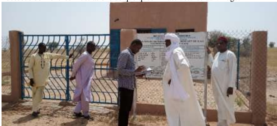
Photo 32 : Aperçu du système de captage du village de Kao.
