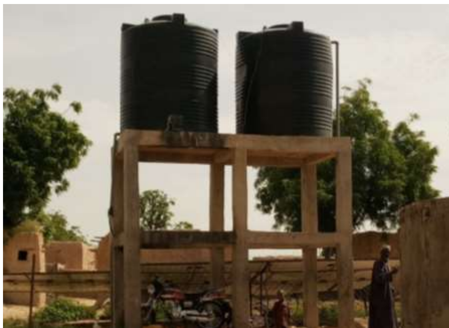
Photo 26 : Aperçu du PEA existant au village de Sansani/Garagoumsa. Source : mission terrain, octobre 2022
