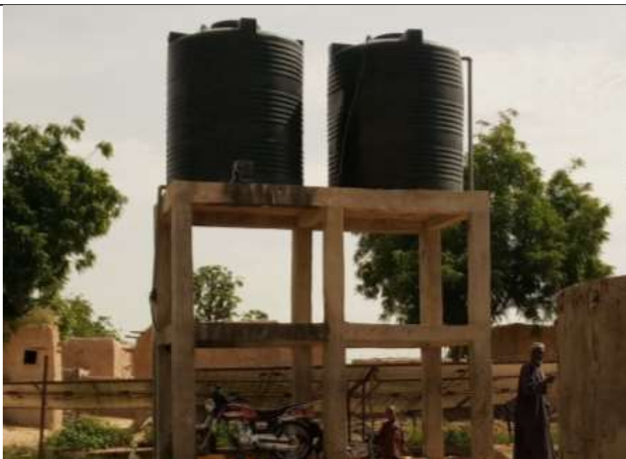
Photo 22 : Aperçu du PEA existant au village de Sansani/Garagoumsa.
