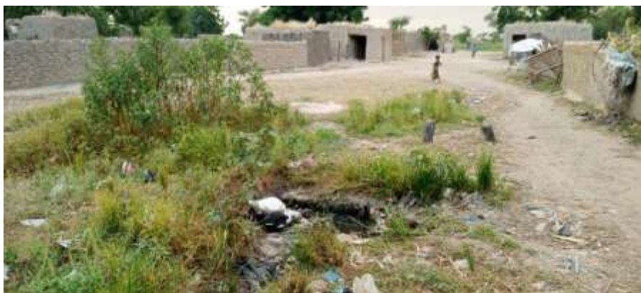
Photo 20 : Aperçu de l'habitat et l'exécutoire de la FMPH en panne.
