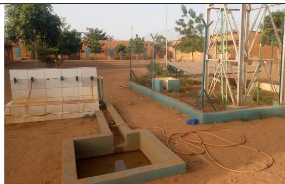
Photo 2 . Vue du point d'eau Ecole Dan Zama Koira
