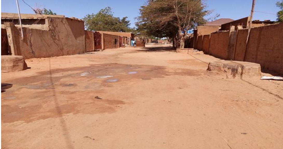
Photo 6. Emplacement des fosses septiques dans une rue abritant une extension du réseau de distribution d'eau à Koira Tegui (Source : EIES, AGECI)
