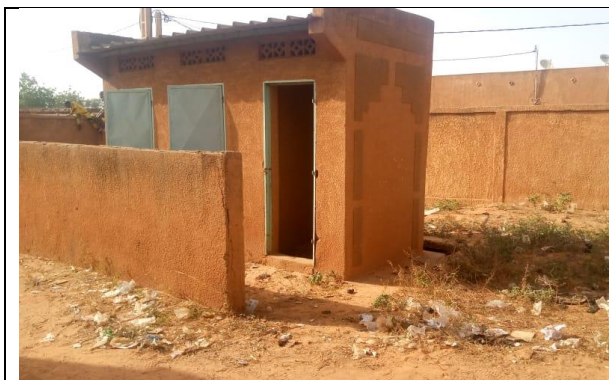
Photo 1 . Latrines Ecole Koira Tégui 1,
