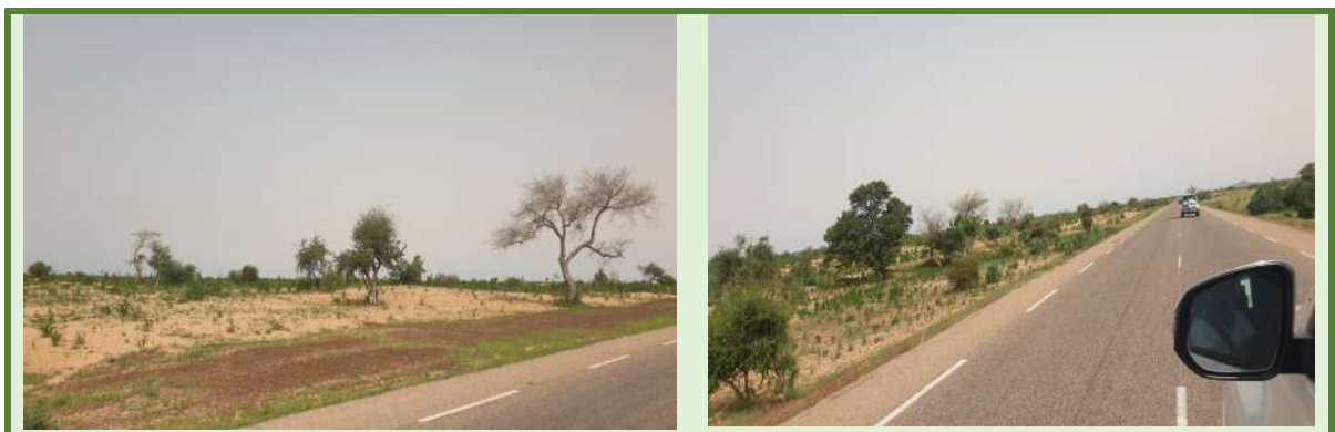
Planche photographique n° 3: Aperçu de la végétation sur le tronçon de la conduite de transfert des eaux (Source : Mission EIES-SPEN, BEGEC 2023)
