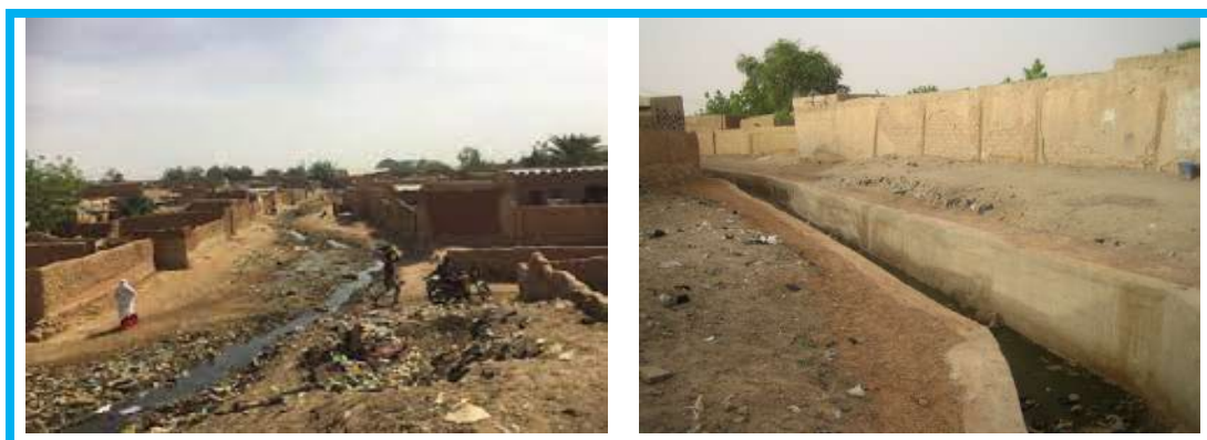
Planche photographique n° 12: Aperçu du système d'évacuation des eaux usées au niveau de la zone du sous projet (Equipe consultant, 2023)
