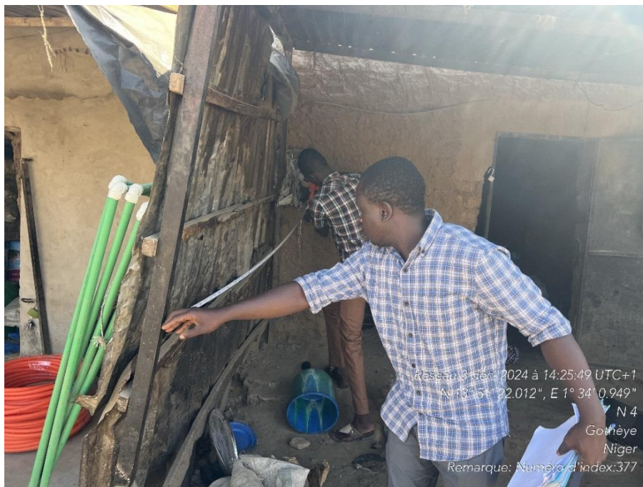
Photo 8 : Mesure d'un hangar à démolir lors des travaux
