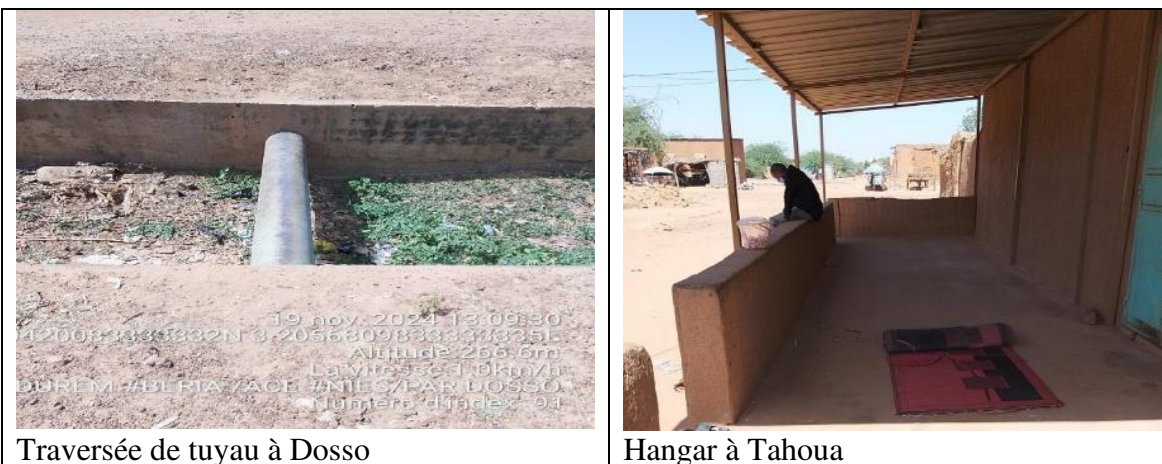
Photo 12 : Exemple de quelques types de biens susceptibles d’être impactés par les travaux Source : Étude EIES et PAR, PIDUREM, 2024
