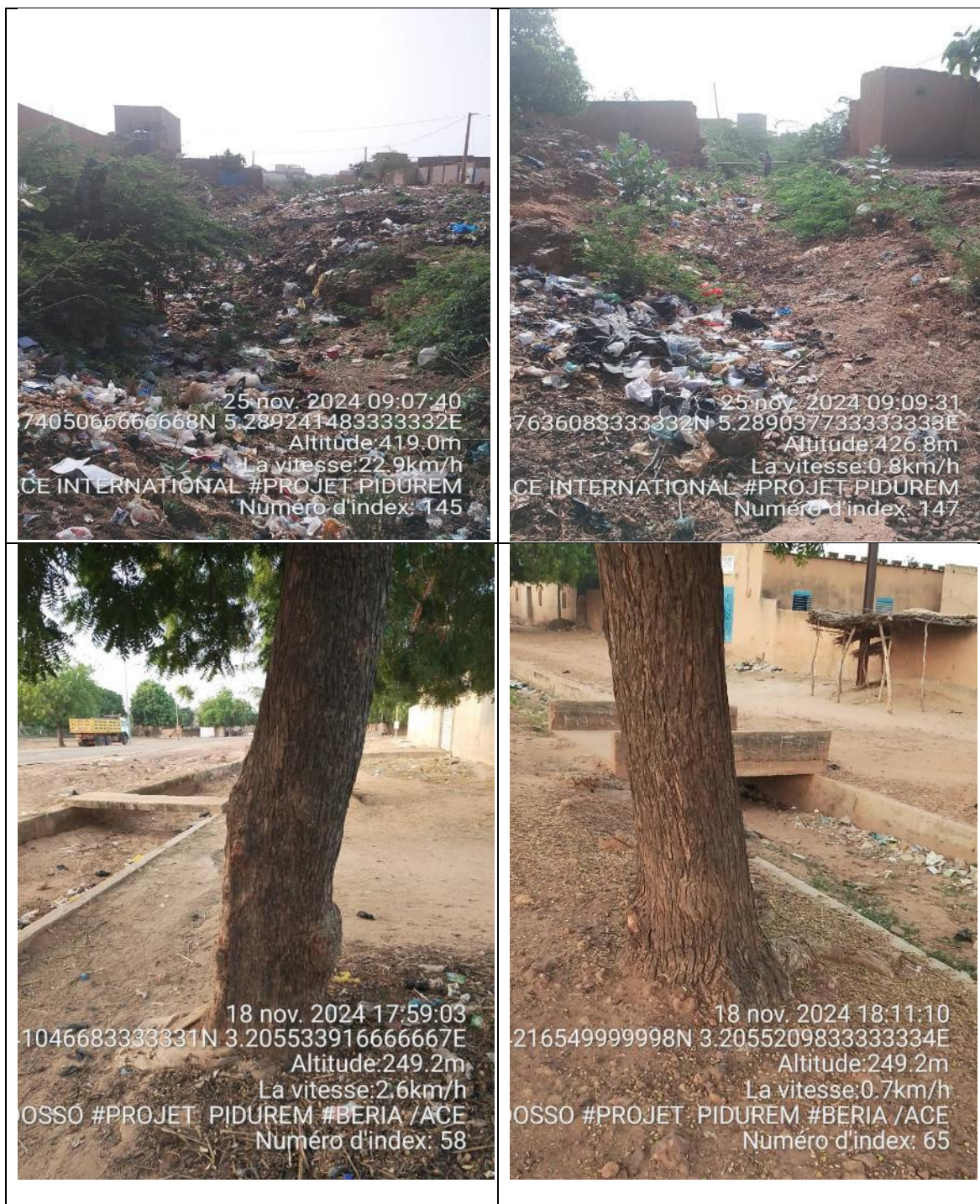
Photo 15 : Stagnation des eaux dans des caniveaux dans la zone du projet
