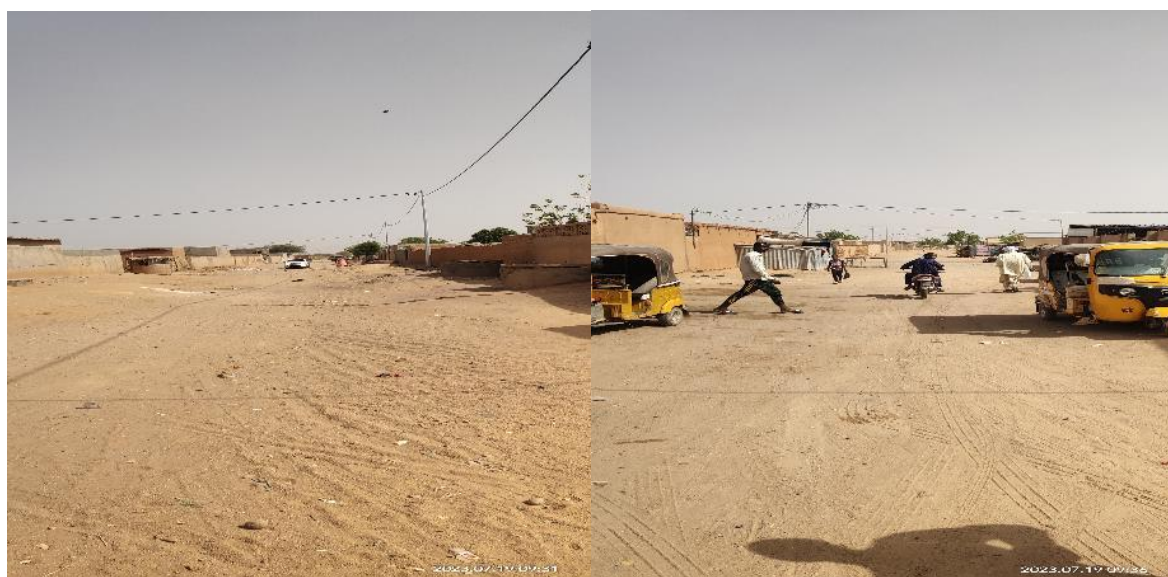
Photo 1: Rues drainantes du quartier EST
