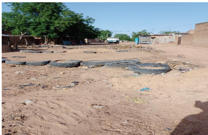
Photo 13: Dispositif anti-érosion au de la Rue Bastos – Batagougoussou
