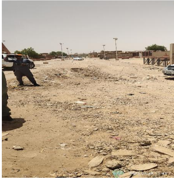
Photo 2: Rue drainante de l'ancien Hopital – Kori AMARZAGADEM
