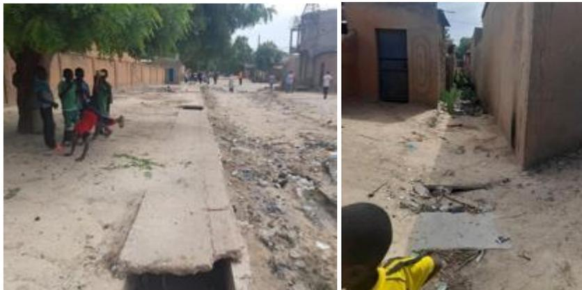
Photo 10 : Canal couvert par des dalettes (gauche) et Canal en mauvais état (droite).
