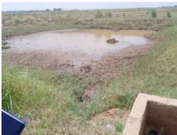
Photo 1 : Aperçu du dysfonctionnement de réseau de drainage Source : FEED-Consult (Mai 2025)
