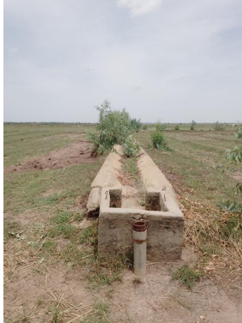
Photo 1 : Ouvrage de prise pour l'irrigation Source : (FEED-Consult)
