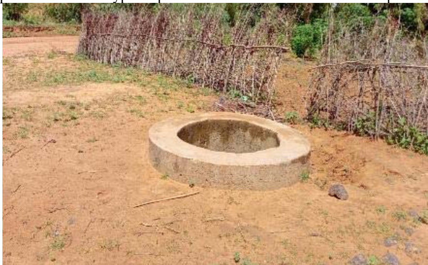
Photo 4 : puit maraicher cimenté sur le site
