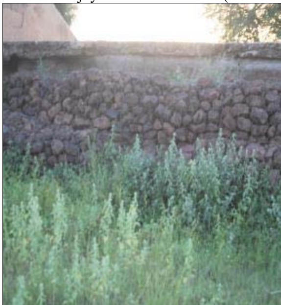
Partie déversant en gabion et maçonnerie
