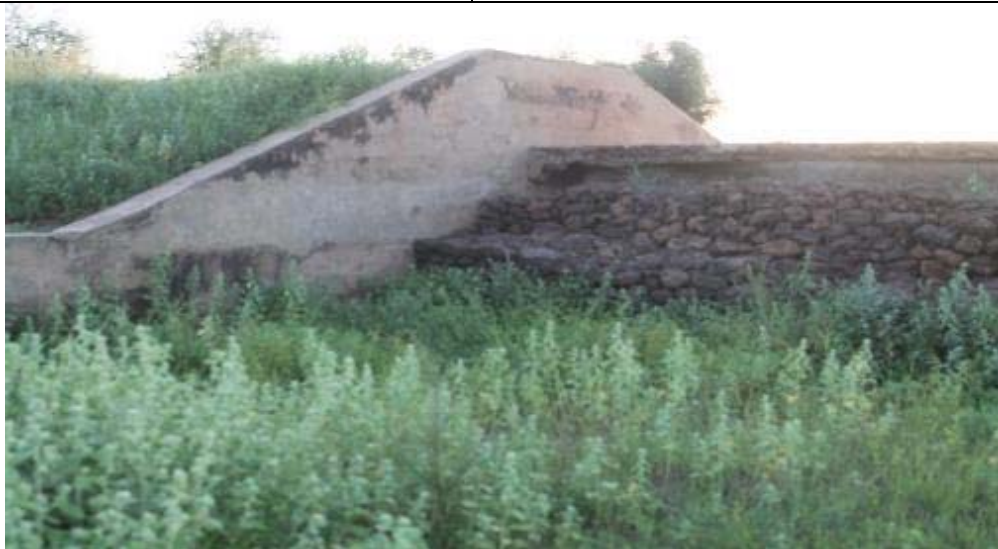
Bajoyer en béton armé
