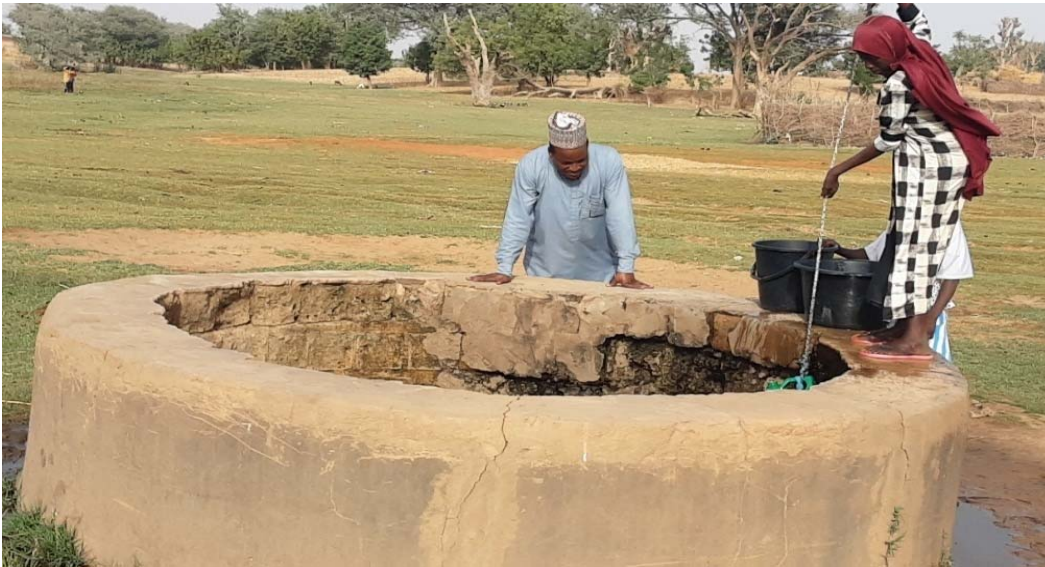
Photo 3 : Puit traditionnel cimenté (3m de profondeur) sis au niveau de la zone d'épandage du seuil
