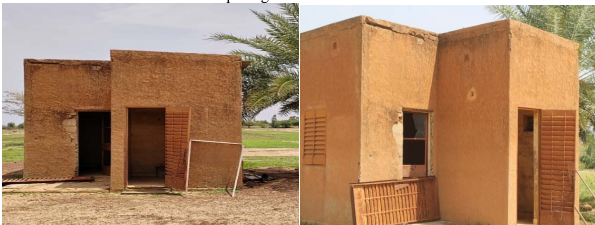
Planche 6 : Vue de face (photo 5) et de profil (photo 6) de la case de passage à l'état actuel
