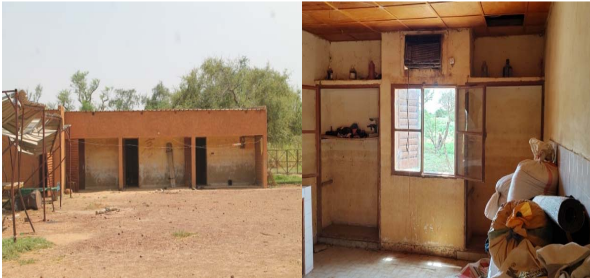
Planche 5 : Vue du local administratif (photo 3) et du laboratoire (photo 4)
